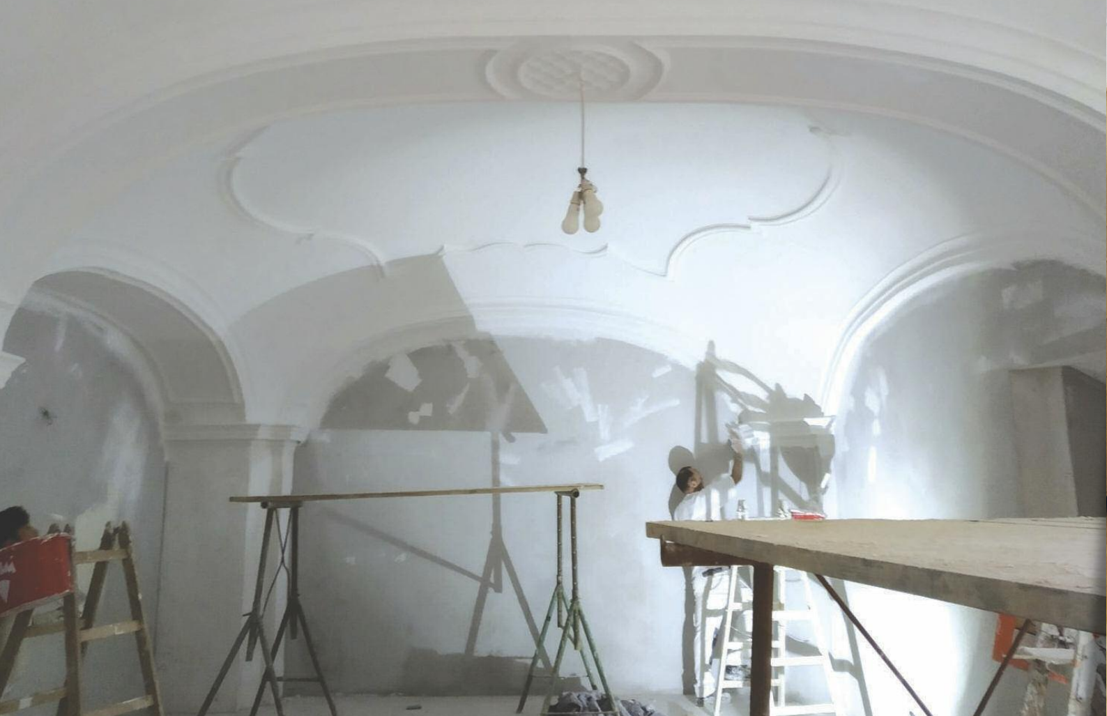
Grundierung des Saales.
